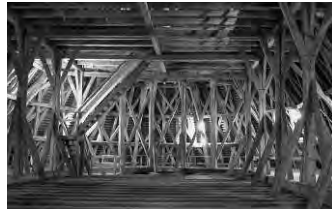
Abb. 20: Dachtragwerk St. Michael, Schwäbisch Hall
