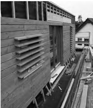
Abb. 73: Überwachung der Baustelle, Wohnhaus, Arch.: 2-box
