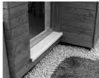
Abb. 66: Fenstereinbau, Abdeckung, Spritzschutz, Wohnhaus, Arch.: 2-box
