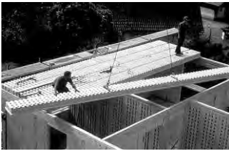
Abb. 19: Montage von Deckenelementen aus Massivholz
