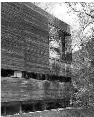
Abb. 75: Bauunterhalt nach Bezug ist erforderlich, FW- und Kulturhaus Hittisau, Arch. cukrowitz.nachbaur
