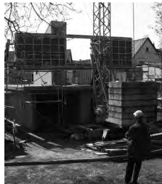
Abb. 74: Überwachung der Baustelle, Wohnhaus, Arch.: 2-box
