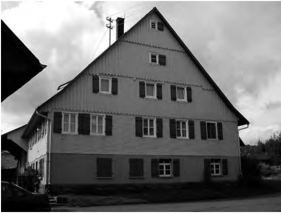
Abb. 2.11 Wohn- und Wirtschaftsgebäude im Landkreis Calw
