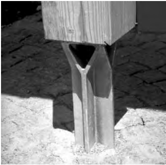
Abb. 71: Sockelbereich, Spritzschutz
