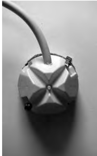
Abb. 17: luftdichtes Steckdosengehäuse
