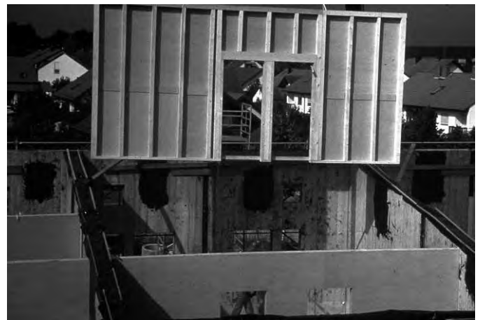
Abb. 20: Innenwandelement wird per Kran in das obere Geschoss eingesetzt
