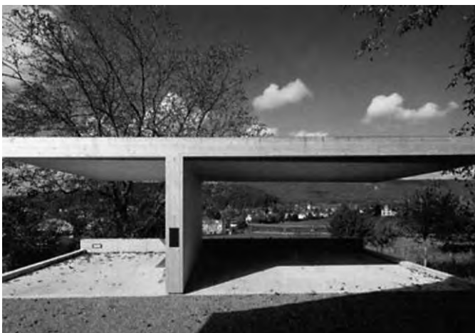
Abb. 1: Carport mit weit auskragender Holzkonstruktion (LIGNATUR)
