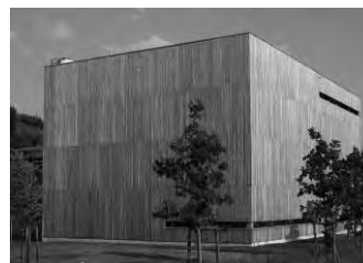
Abb. 68: vert. Schalung, Fugeneinteilung, Abdeckung der Aufsichtsflächen, Heizkraftwerk
