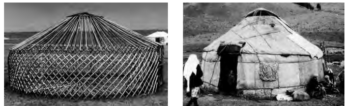
Abb. 1, 2: Zeltbehausung von Nomaden in der Mongolei. Der bewohnbare Raum wird ermöglicht durch ein tektonisches Gerüst aus Holzstäben, das mit einer schützenden Schicht umwoben wird.
