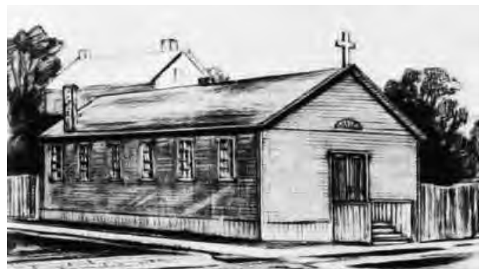
Abb. 2: St. Mary's Church, Chicago gilt als erster Holzrahmenbau, 1833 Erbauer: Augustine Taler
