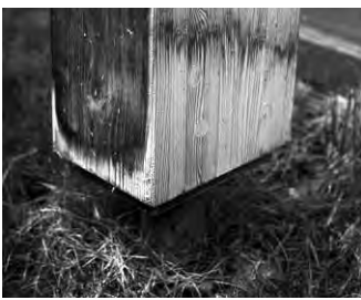
Abb. 72: Sockelbereich, Spritzschutz
