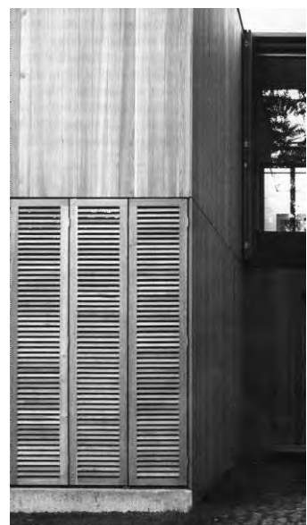
Abb. 70: Sockelbereich, Spritzschutz, Wohnhaus, Arch.: H.N.Schneider
