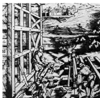
Abb. 15: Abbund eines Fachwerkhause, zeitg. Darstellung
