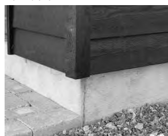
Abb. 69: Sockelbereich, Spritzschutz, Eckausbildung Fassade
