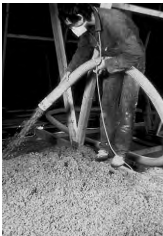
Abb. 42: Einbringung von Zellulose in eine Holzdecke
