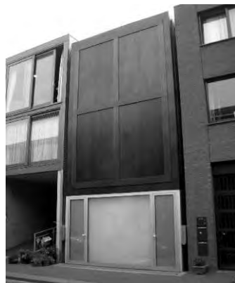
Abb. 45: Physikalischer Holzschutz durch Lackierung der Holzoberfläche
