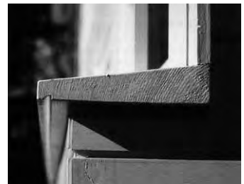
Abb. 67: Fenstereinbau, Abdeckung
