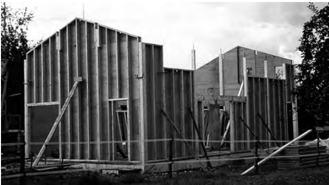
Abb. 18: Holzhaus im Rohbau: Innere Beplankung statisch wirksam
