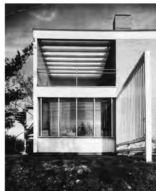
Abb. 3: Wohnhaus in Holzrahmenbauweise Cambridge 1939, Arch.: Walter Gropius und Marcel Breuer
