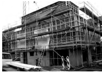
Abb. 34: Baulicher Holzschutz während der Bauausführung, Arch.: 2-box
