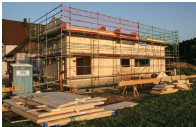
Schnelle Bauzeit – schon nach wenigen Tagen war Richtfest!
