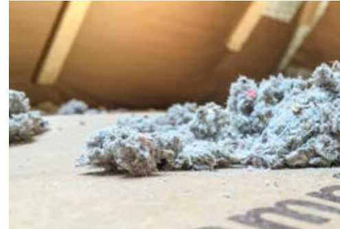
Dämmung mit Zellulose
