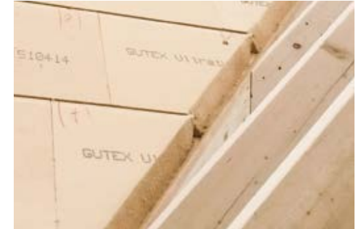
Dämmung mit Holzfaserplatten, © Foto: Zimmerei Schleh
