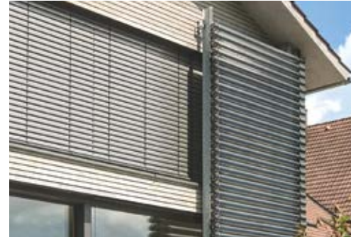
Einfamilienhaus in Glatten, Solarthermie mit Stückholzheizung, S. 40 © Foto: Lieb + Lieb Architekten
