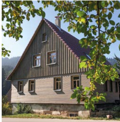
Im Leibgedinghaus entstehen gesunde Praxisräume.
