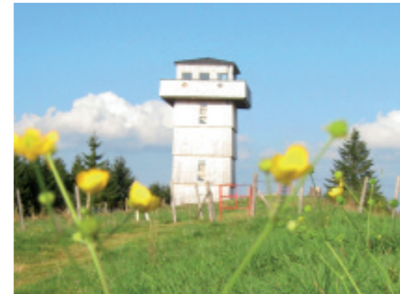
Foto: Holzbau Buhmann, Weitnau
